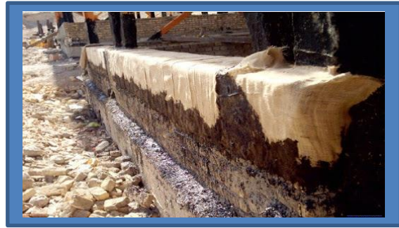
عایق کاری پی دیوار
