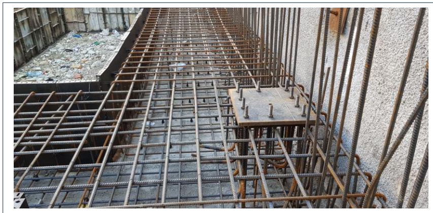
نمونه آرماتوربندی و شناژ فونداسیون
