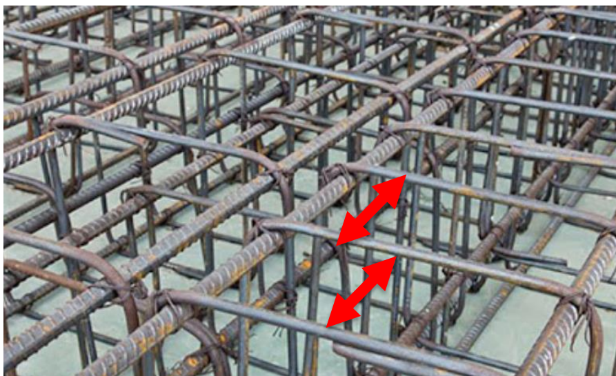
خاموت گذاری طبق فواصل مشخص
