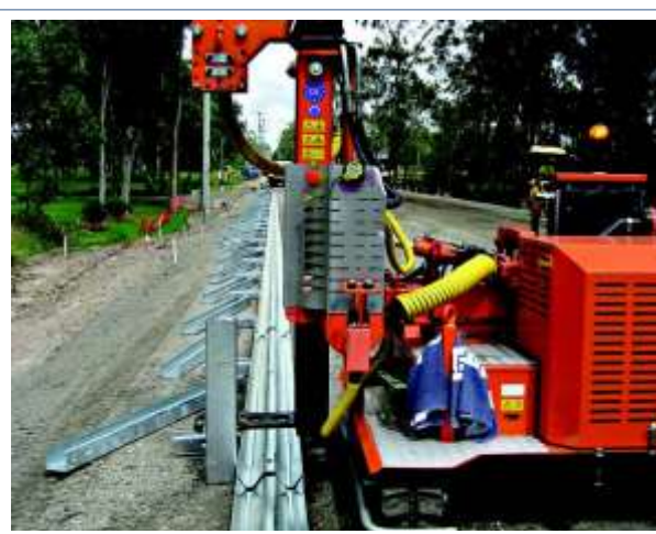
دستگاه نصب گاردریل
