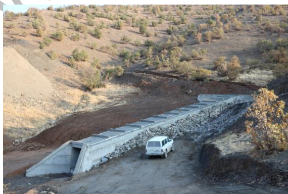
( بلوکاژ پشت کوله پل )
