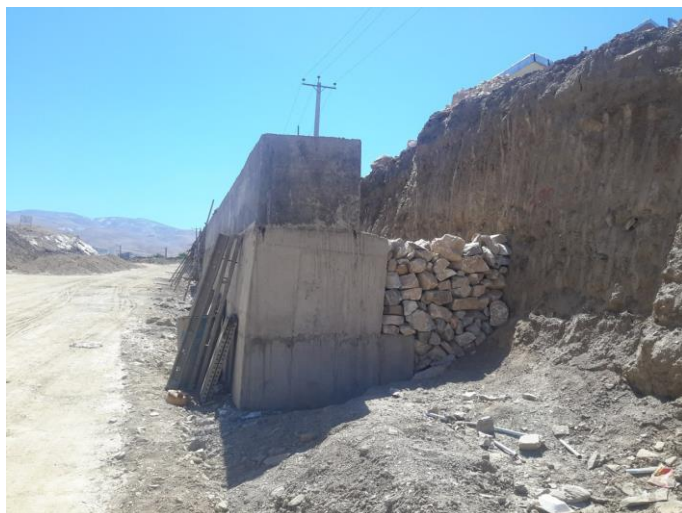
(اجرای بلوکاژ پشت دیوار حائل)
